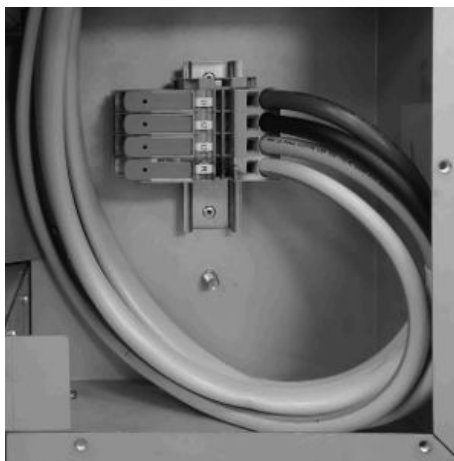
Abb. 24: Klemmen in der Anschlussbox
